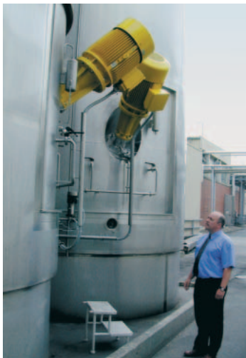
Montaje en tanque mediante brida lateral bajo el nivel del líquido, CIP
